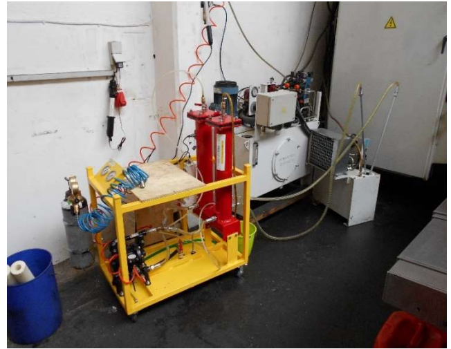
Reinigung einer Hydraulikeinheit inkl. Filterwechsel und Hydrauliköl ISO VG HLP 46 von einer Fräsmaschine.
